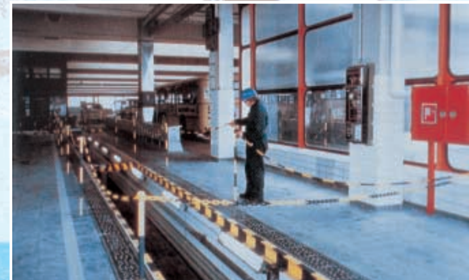
Mit Ketten wird die unbenutzte Arbeitsgrube gegen Hineinstürzen gesichert. ▼
