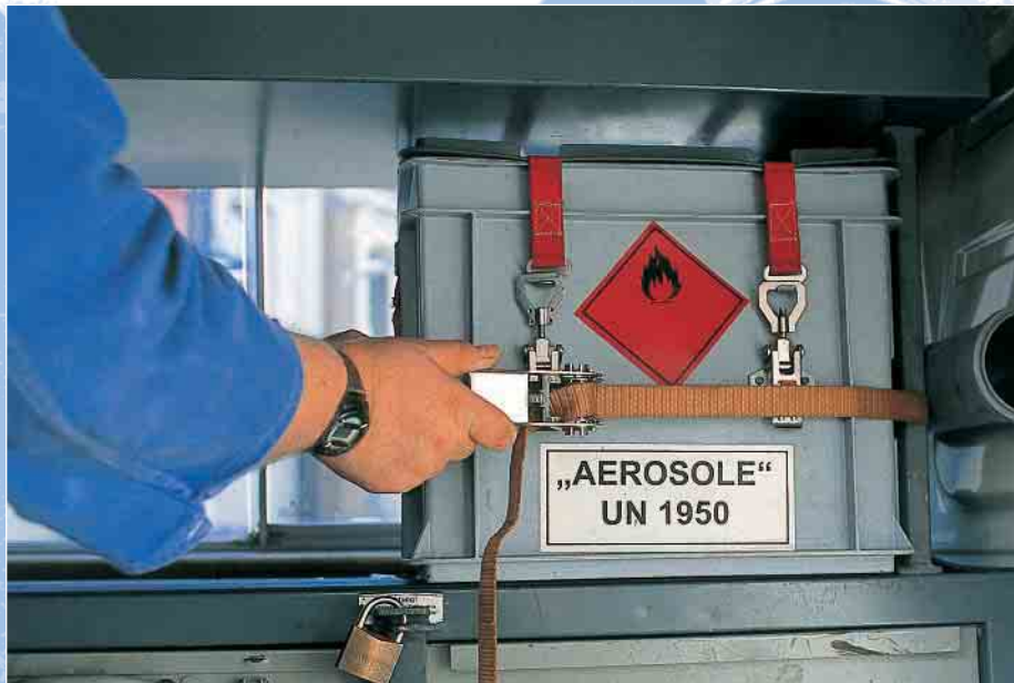
Mit geeigneten Zurrgurten lassen sich auch kleinere Behälter sichern. ▼
