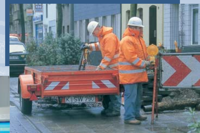
Auch bei kurzzeitigen Arbeiten im öffentlichen Verkehrsbereich z. B. bei der Erneuerung eines Hausanschlusses, müssen die Mitarbeiter Warnkleidung tragen.
