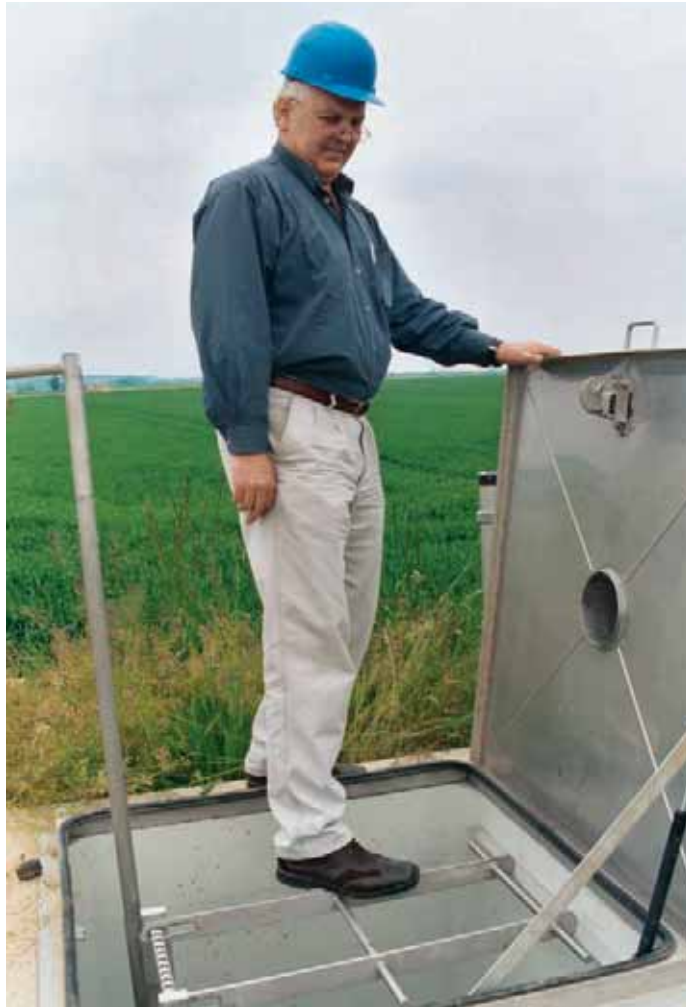
Bild 2: Der Leiterkopf dieses Typs bietet zwei Funktionen: - im abgeklappten Zustand Absturzsicherung - im aufgeklappten Zustand Haltvorrichtung
