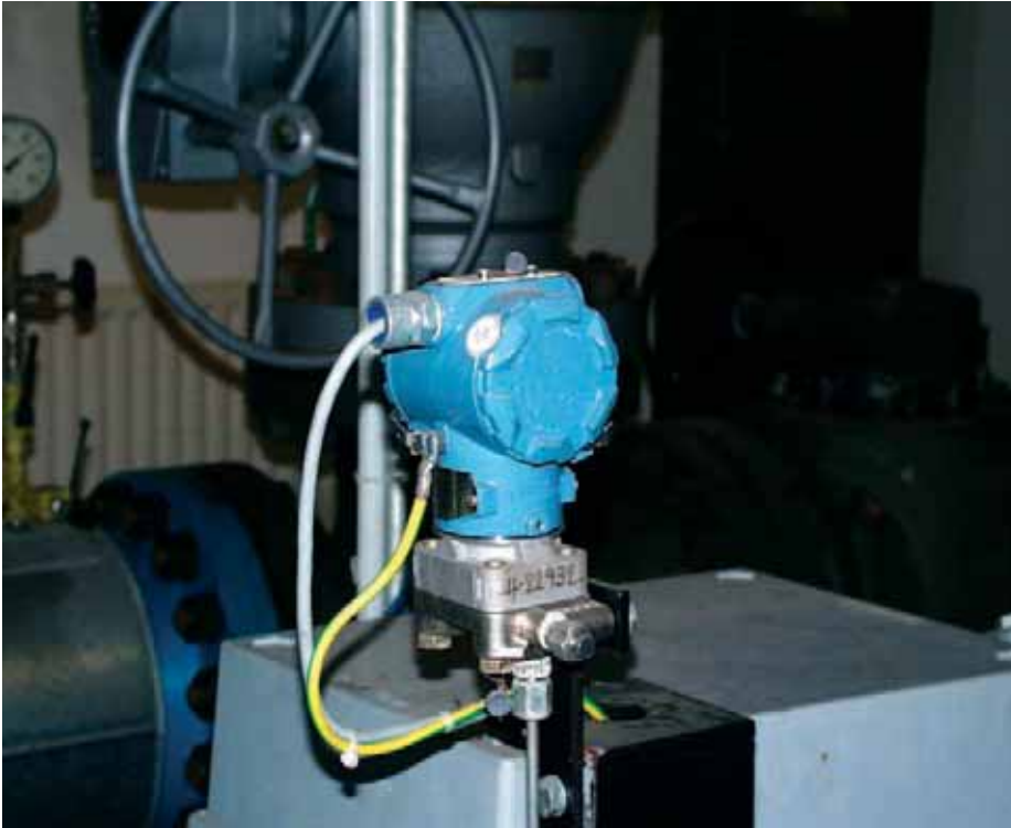
Drucktransmitter, Zündschutzart Eigensicherheit
