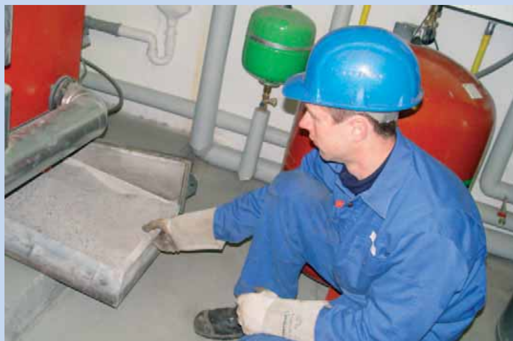
Beim Umfüllen der Asche in geeignete Behälter, muss ein Aufwirbeln vermieden werden. Vorsicht: Die Asche kann mitunter noch sehr heiß sein.
