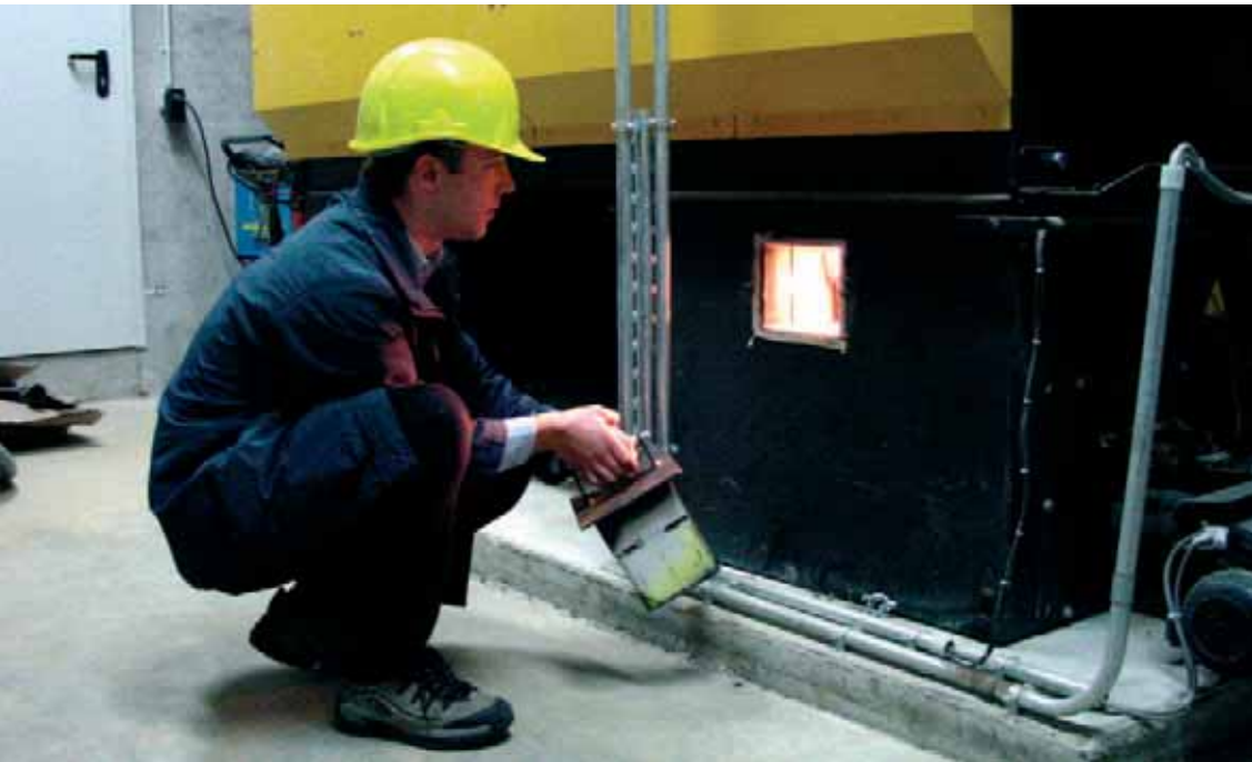
Sichtkontrolle durch einen Blick in den Feuerraum eines Pellet-Heizkessels.
