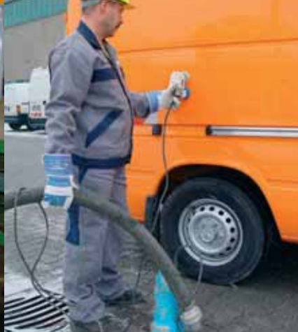
Als Speisepunkt für eine kleine Baustelle kann auch das Bordnetz eines Fahrzeuges dienen, sofern die Abschaltung im Fehlerfall durch eine 30 mA-Fehlerstrom-Schutzeinrichtung gewährleistet ist oder die Anforderungen der Schutzmaßnahmen Schutztrennung oder Schutzkleinspannung erfüllt sind.
