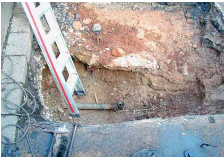
Geöffnete Hausanschlussleitung
