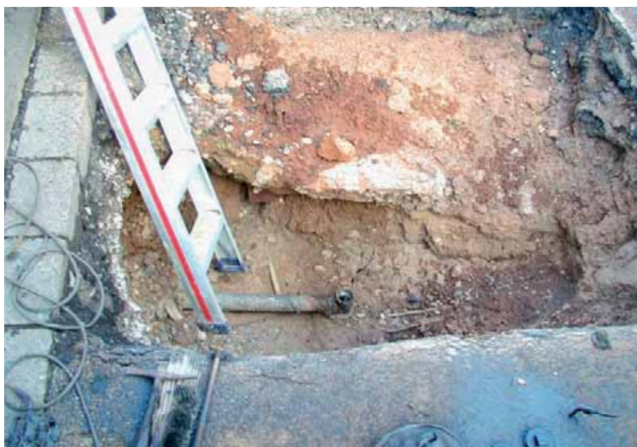
Geöffnete Hausanschlussleitung
