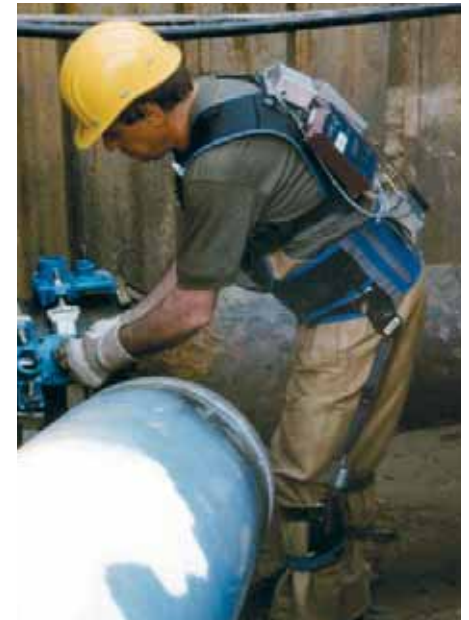
Cuela-Messsystem bei Montagearbeiten im Gasversorgungsnetz
