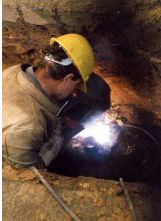
Auch bei Schweißarbeiten sind die Grenzwerte einzuhalten
