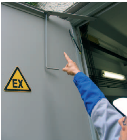
Feststellbare Tür einer GDRM-Anlage mit Potentialausgleich und Kennzeichnung der Explosionsgefahr
