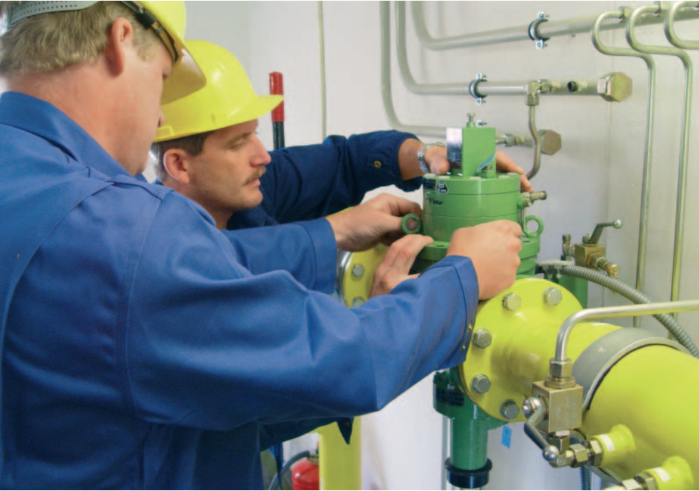
Zwei Mitarbeiter, davon ein Sachkundiger, bei Wartungsarbeiten an einem Druckregler
