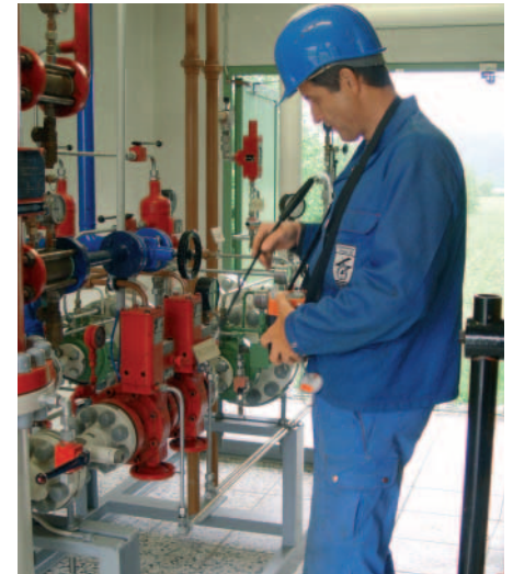
Prüfung der Gasfreiheit im Raum
