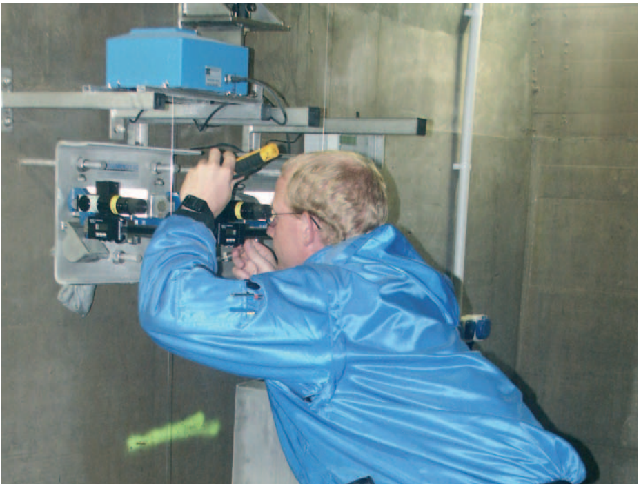
Messung während des Baus
