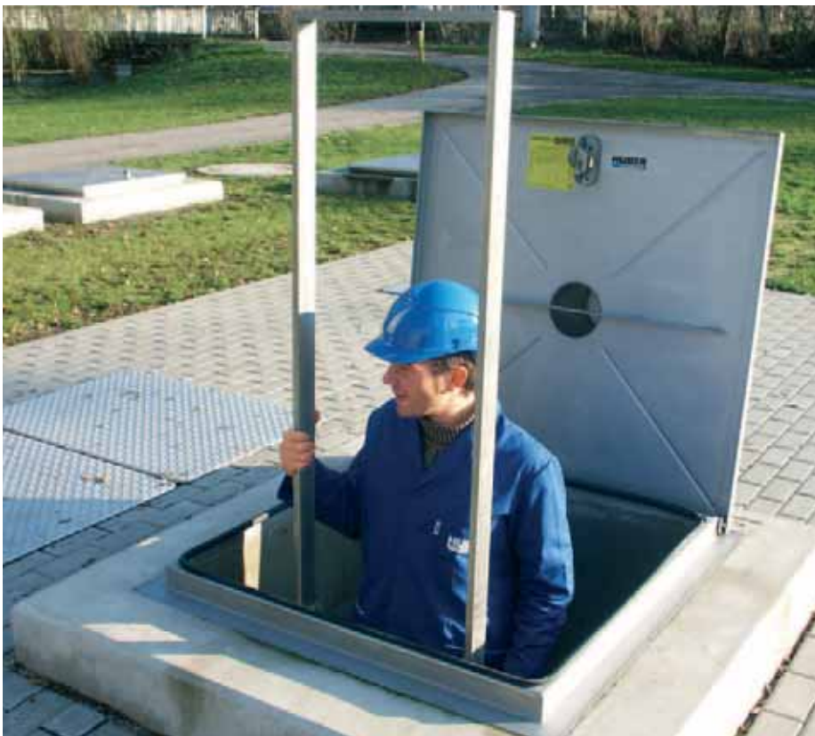
Das Befahren von Schächten in der Wasserversorgung gehört zu den „Gefährlichen Arbeiten“ nach der Unfallverhütungsvorschrift „Grundsätze der Prävention“
