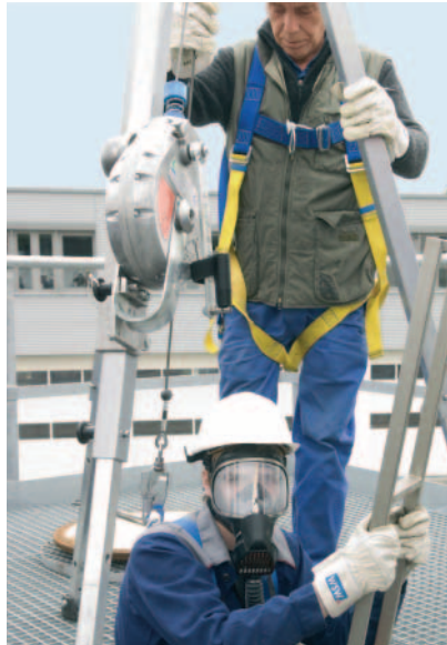
Zum sicheren Einstieg wird eine mobile Einstiegshilfe und als Absturzsicherung das Höhensicherungsgerät benutzt.
