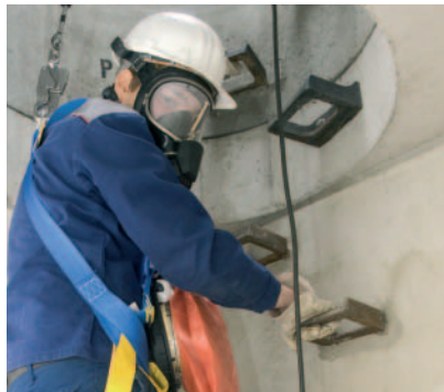
Als Rettungsgeräte sind Chemikalsauerstoffgeräte im Einsatz. Für die Übung werden Trainingsgeräte ohne KO 2 -Patrone verwendet.
