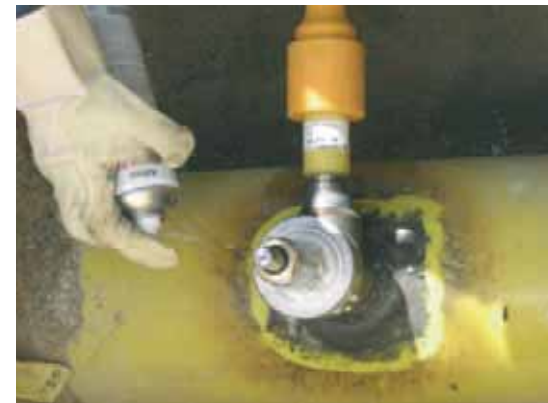
Dichtheitsprüfung unter Verwendung schaumbildender Mittel
