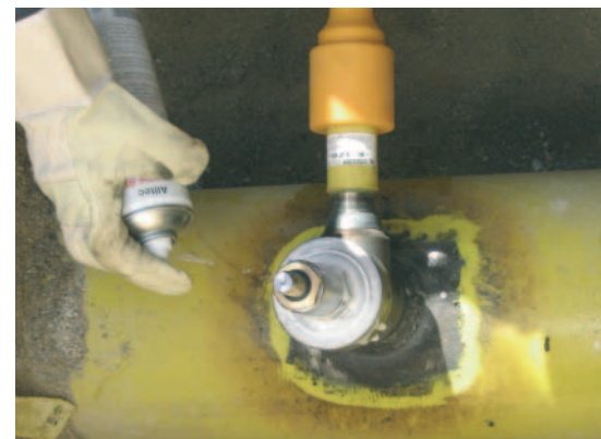
Dichtheitsprüfung unter Verwendung schaubildender Mittel
