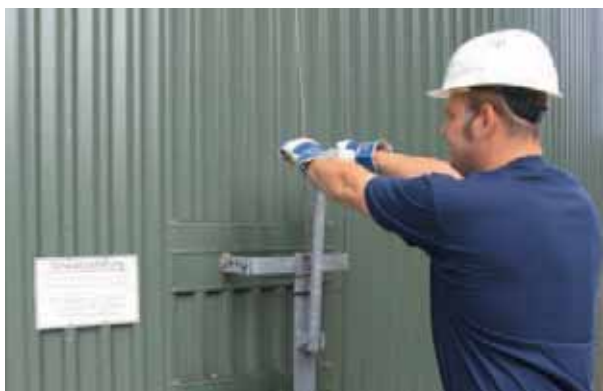
Bedienung der Druckentlastungssicherung bei Schaumbildung im Fermenter.
